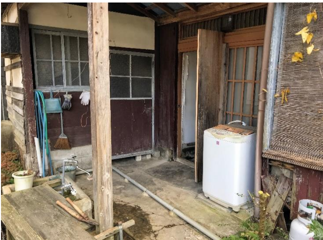
勝手口、洗濯機置き場
