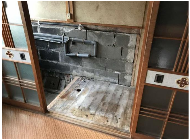
洗濯機置き場
